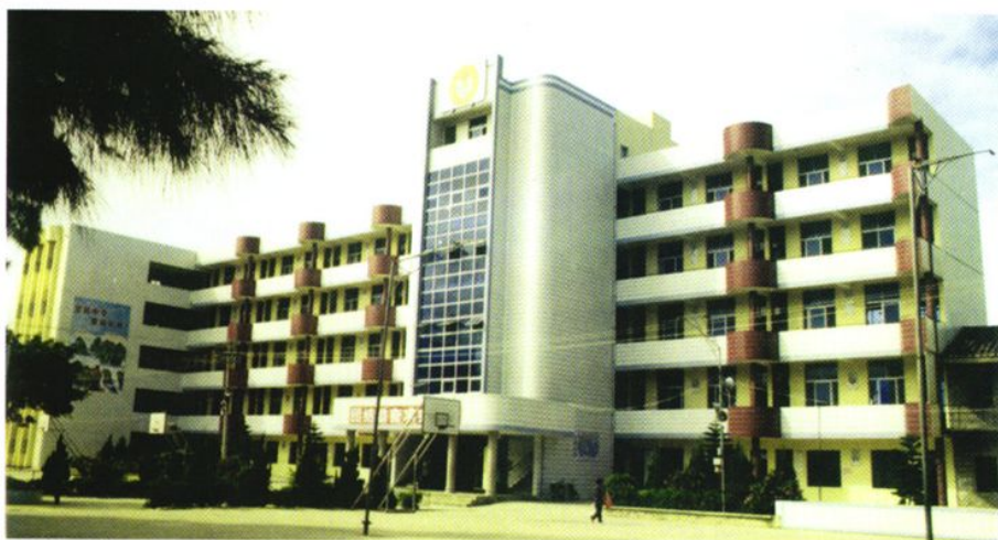
平潭县城关中学教学楼
