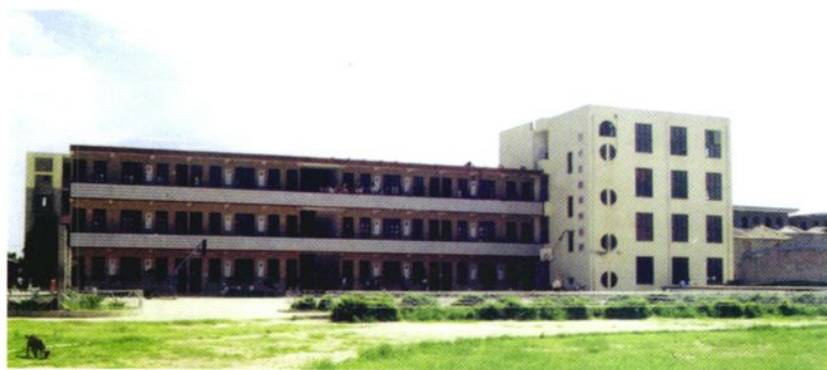
平潭县流水中学教学楼
