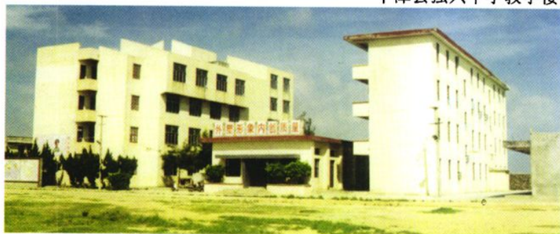
平潭县强兴中学教学楼
