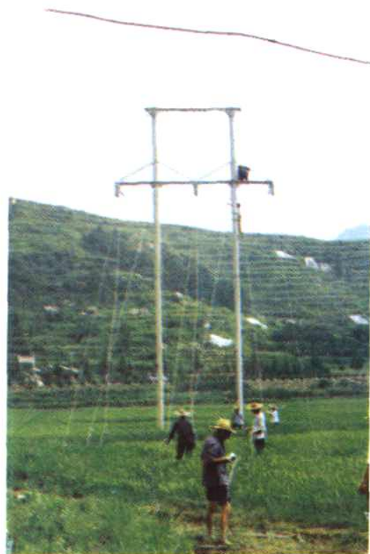
35 千伏输电线路建设
