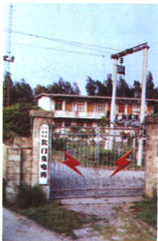
35 千伏坎门变电所
