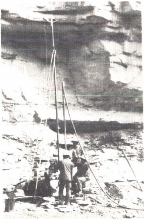
山区地震队正在打井
