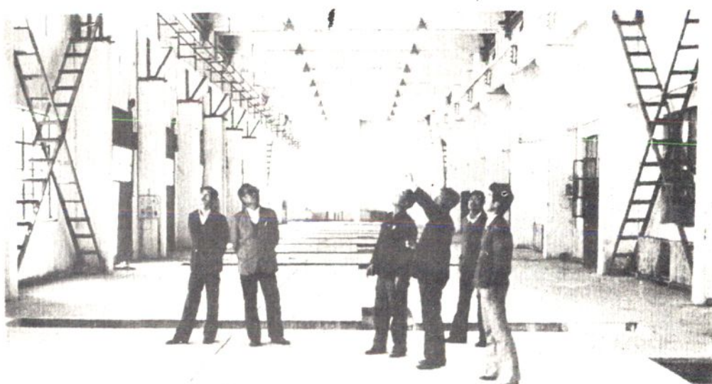
机修站钻修工房竣工验收。
