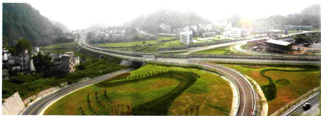
金山高速公路出入口
