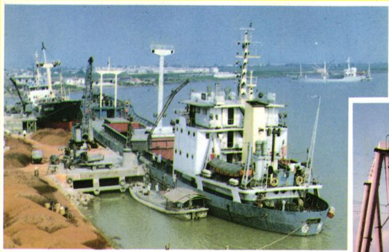
◀ 渔湖港 3000 吨级深水码头
