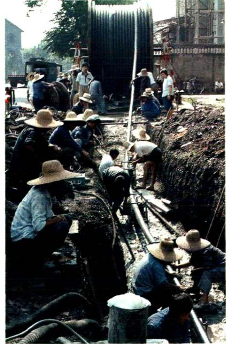
天宝变电站 220 千伏充油电缆敷设施工
