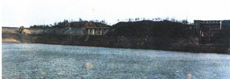
沐浴水库 二级溢洪道闸
