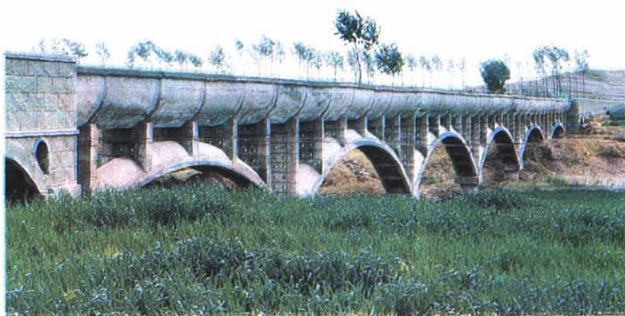
小平水库 李家庄渡槽
