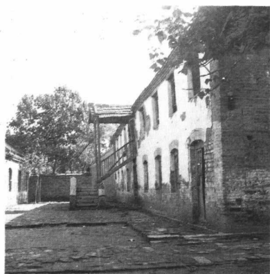
益都县立高等小学堂教学楼
