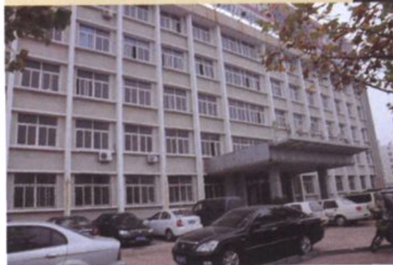
▶ 1986年黄岛区人民检察院旧址
