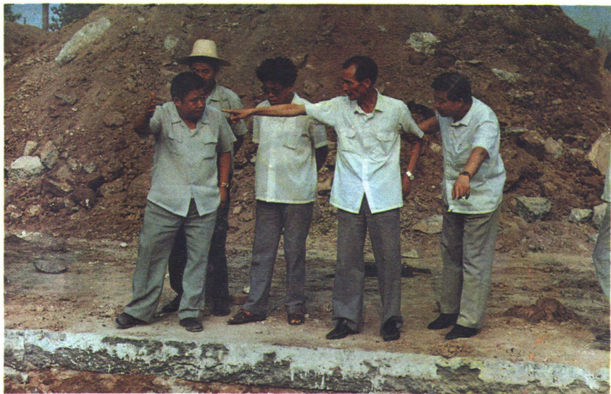
▲河北省交通厅公路处副处长褚桂如（右二）和石家庄市交通局副局长李金玉（右）深入施工现场研究工作
