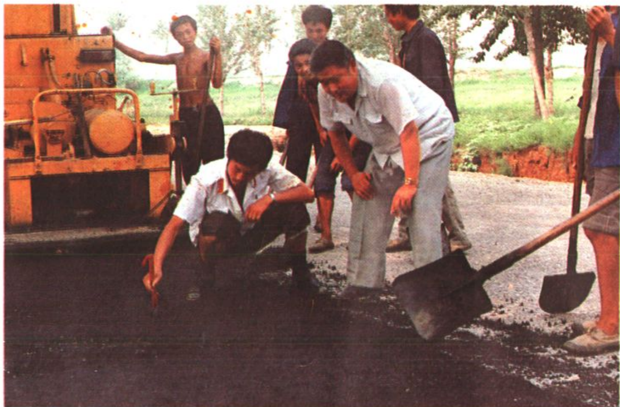
▲ 县交通局长李凤楼检查路面工程质量
