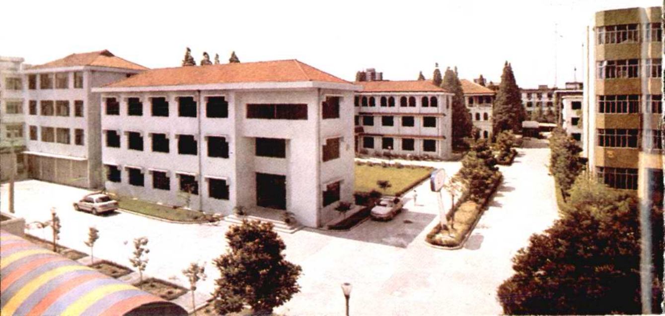
县委、县人民政府办公楼
