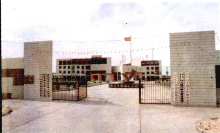
金山卫镇人民政府办公楼
