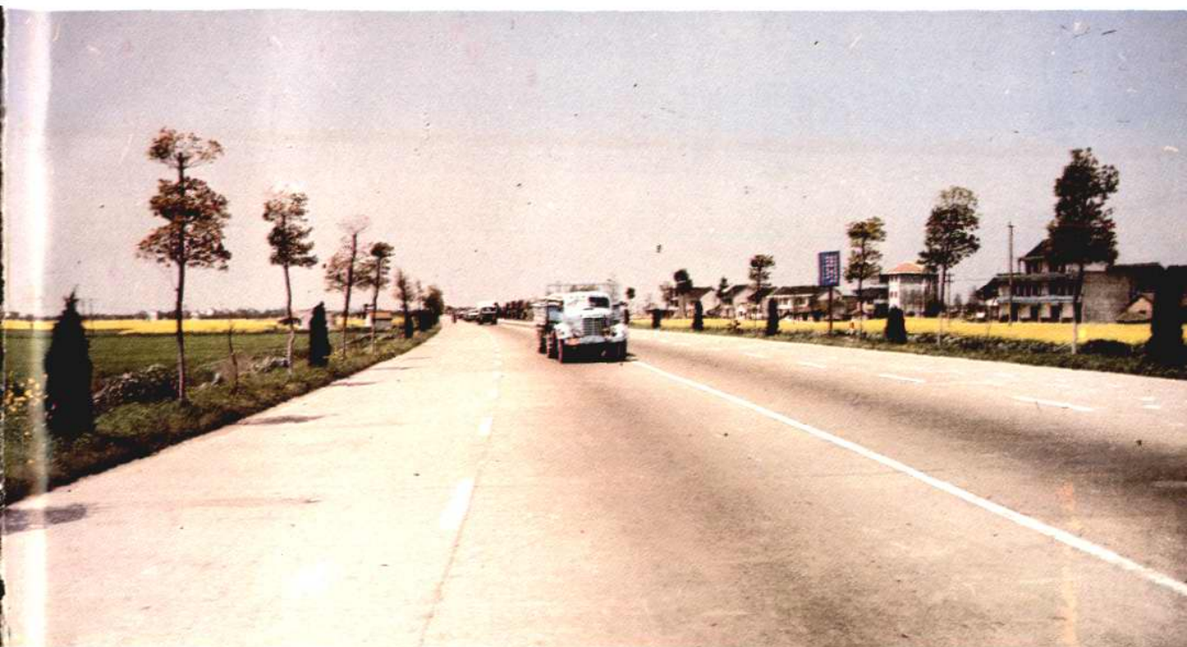
320国道——亭枫公路
