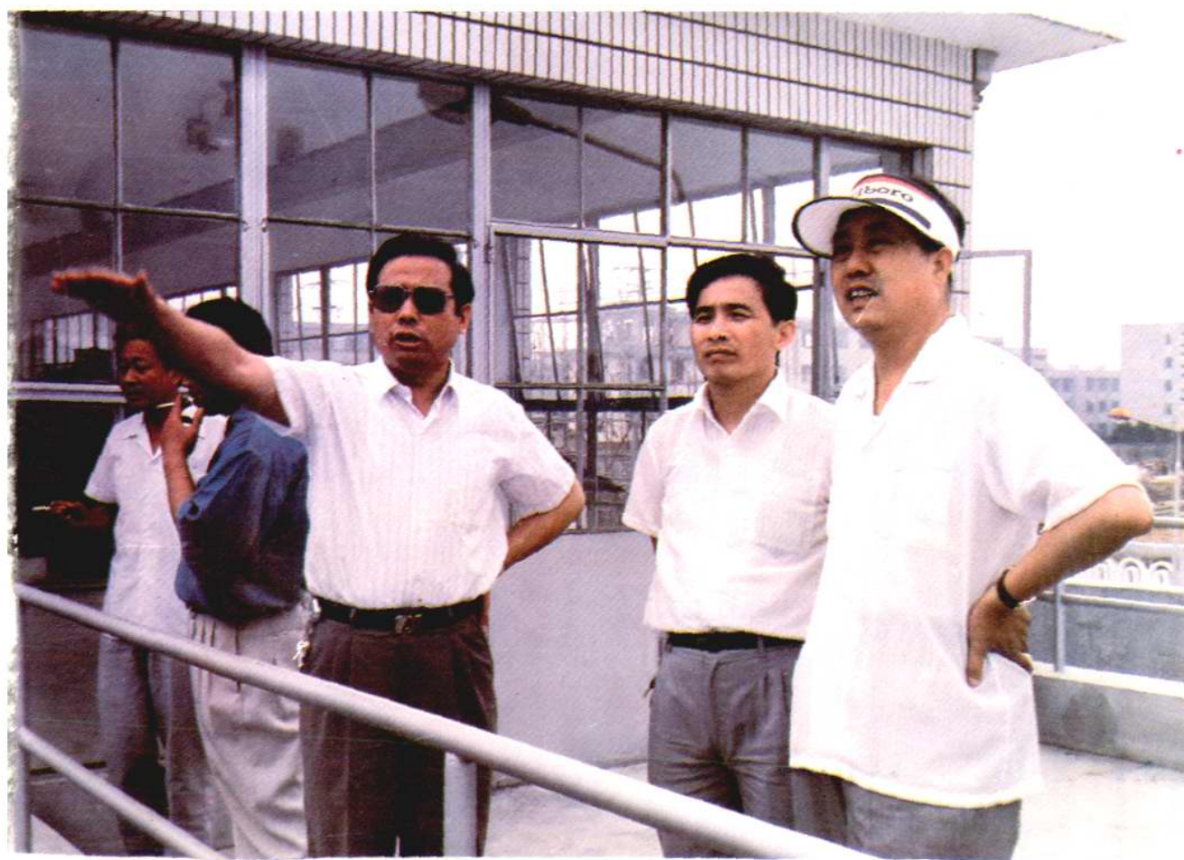
县、局领导在水质净化厂建设工地
