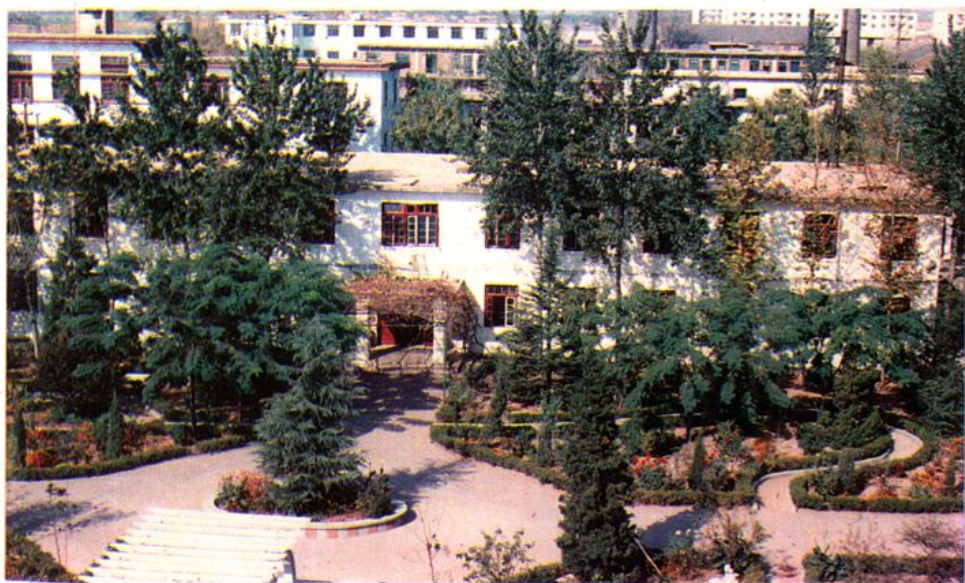
机关办公楼东楼
