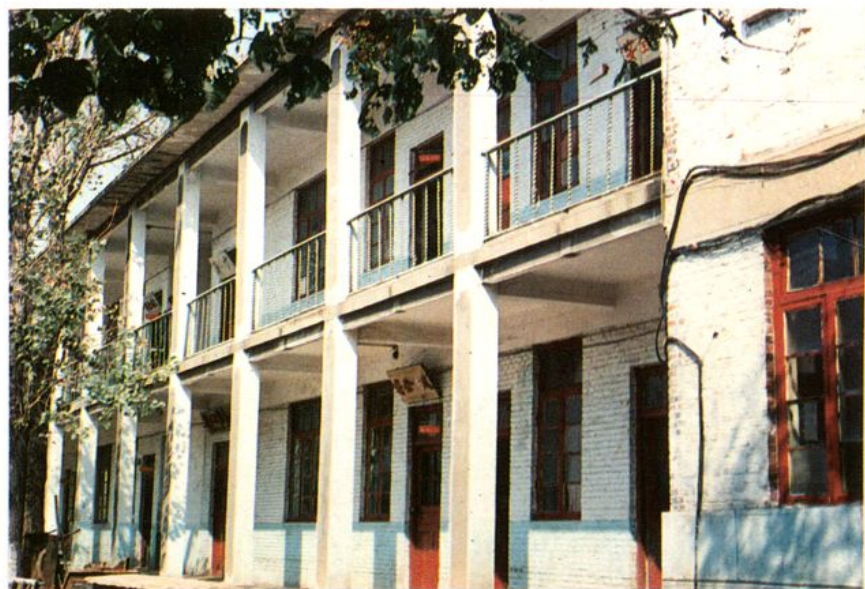
工区办公楼东楼
