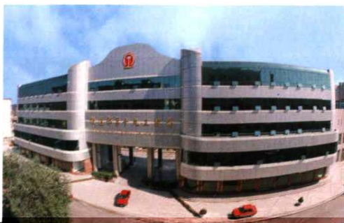
十九局办公楼
