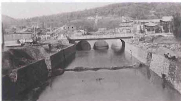
1986年,修建的竹皮河三眼桥段挡土墙
