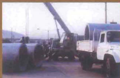
1997年，荆门市市政公司桥涵施工现场
