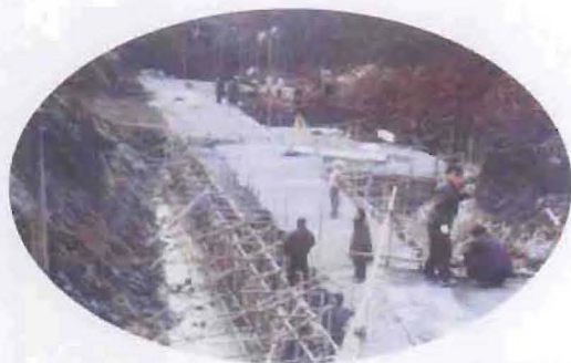
2001年12月20日，市市政公司龙井桥施工现场
