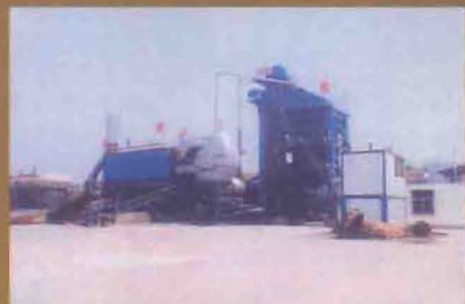
2007年6月，荆门市市政现代沥青混凝土搅拌设备生产运行中
