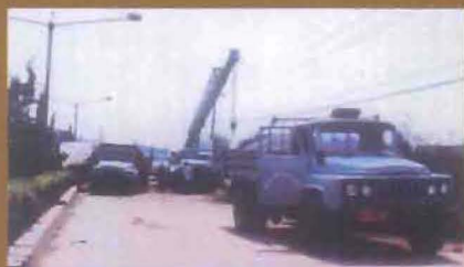
1996年8月，市市政公司机械作业现场
