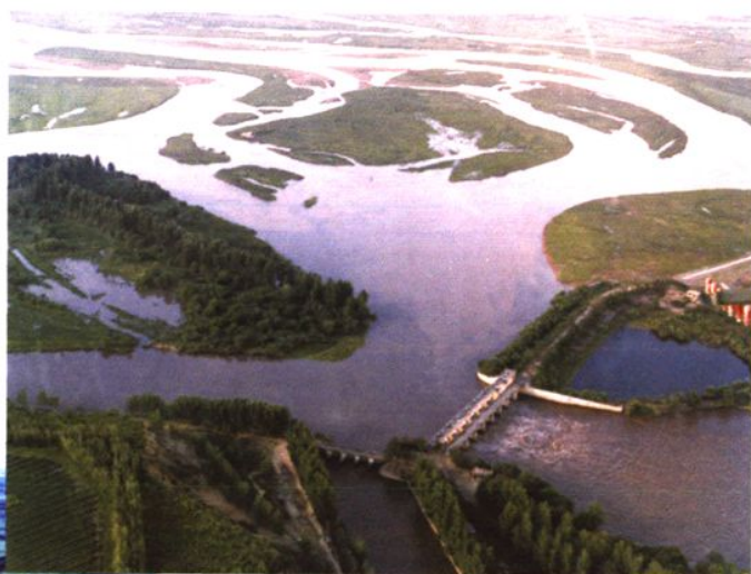
农场气势雄伟的渠首水利 工程（摄于1996年）。
