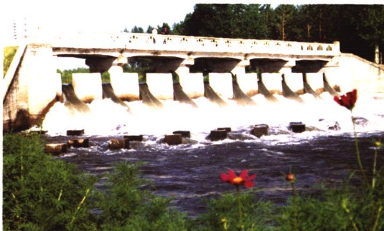
查哈阳总干渠上的一跌水 景观（摄于1997年）。
