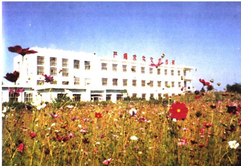
完达山乳业集团查哈阳乳品厂（摄于2000年）。
