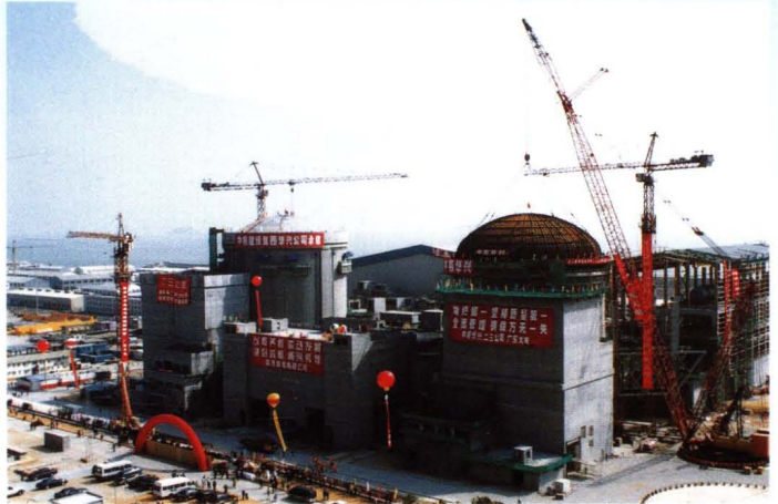
2000年7月,岭澳核电站1号机组穹顶在吊装
