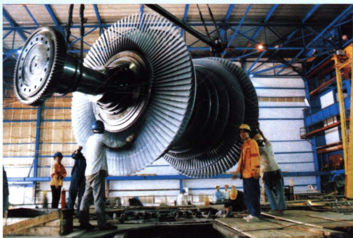
1995年华能汕头电厂1号发电机组（30万千瓦）的汽轮机转子在安装
