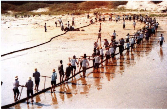
1995年,南澳岛110千伏海底电缆在施工
