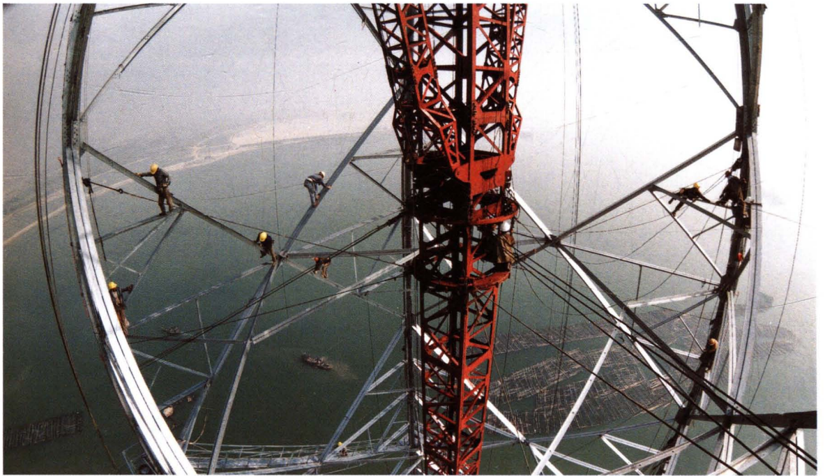
1997年,220千伏汕头海湾大跨越线路的,166米高铁塔在施工
