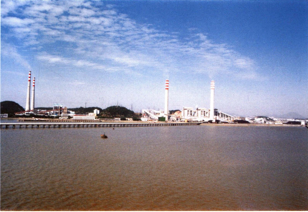
沙角发电基地(沙A 3 \times 20 + 2 \times 30 万千瓦、沙B 2 \times 35 万千瓦、沙C 3 \times 66 万千瓦)
