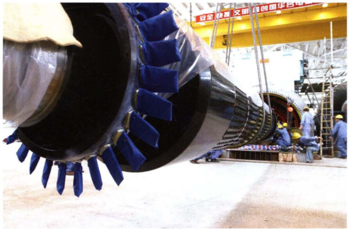
台山电厂1号机组发电机的转子在安装
