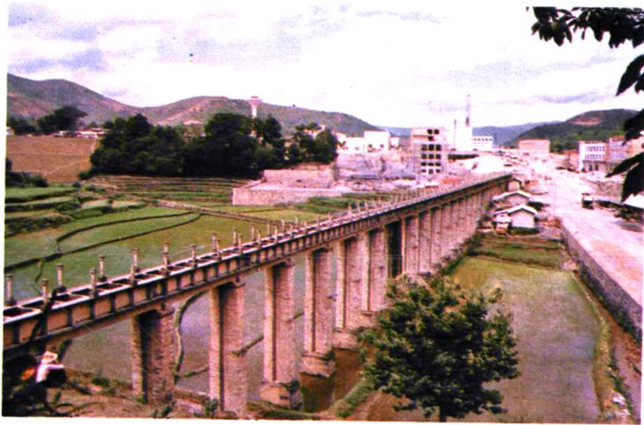
昌宁县共裕水库输水渡槽
