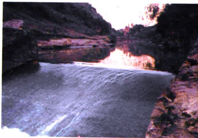
保山市丙麻大沟渠首滚水坝
