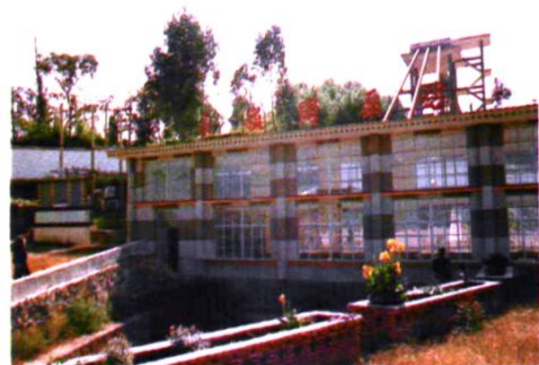
保山市长岭岗泵站
