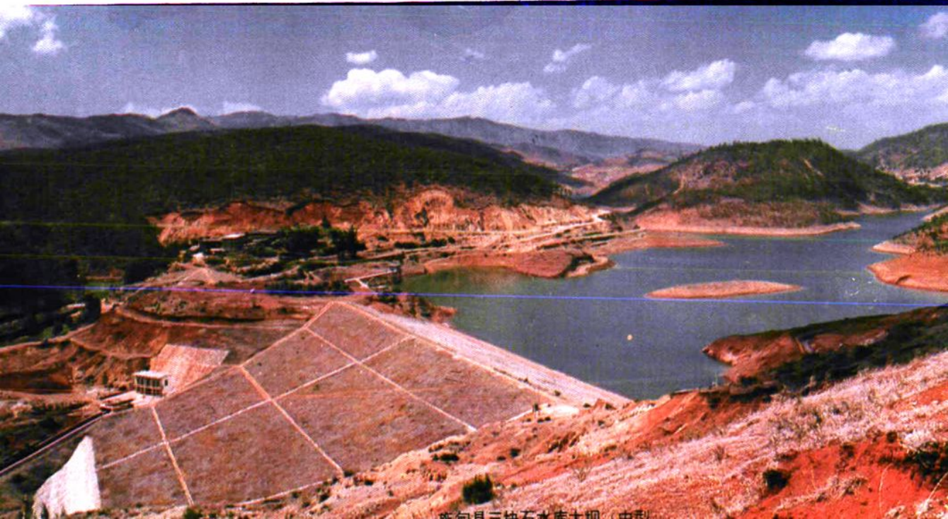
腾冲县三块石水库大坝（中型）
