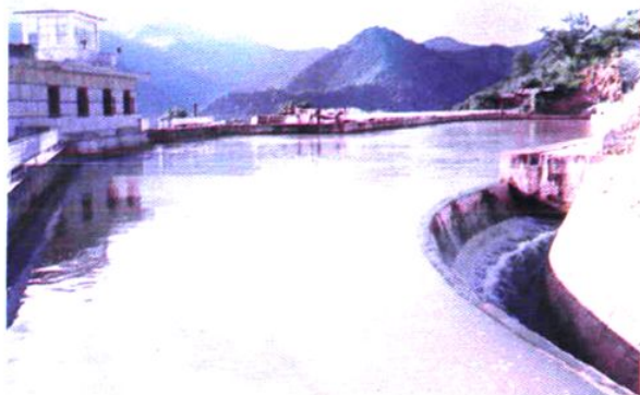
苏帕河三江口电站前池
