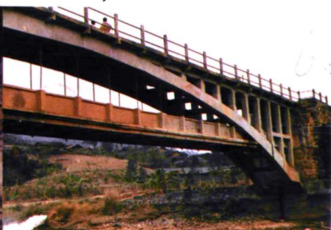
昌宁县三八大沟拱桥渡槽
