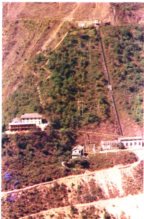
施甸县河尾三级电站厂区
