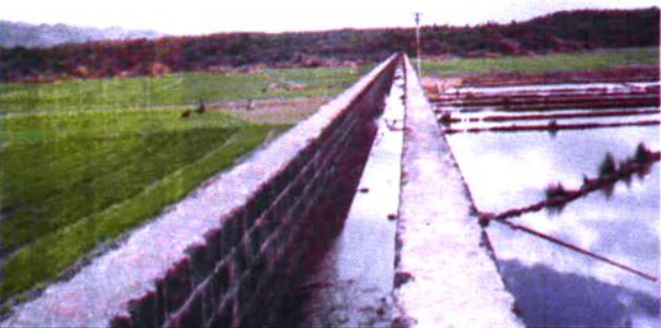
腾冲县大河水库中干渠
