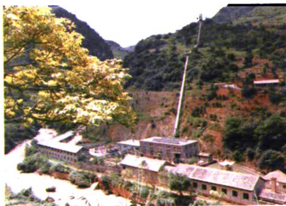
保山市丙麻电站厂区
