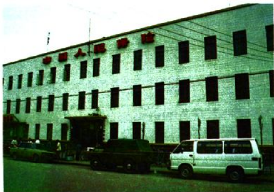
中国人民保险公司 牡丹江市支公司 办公楼
