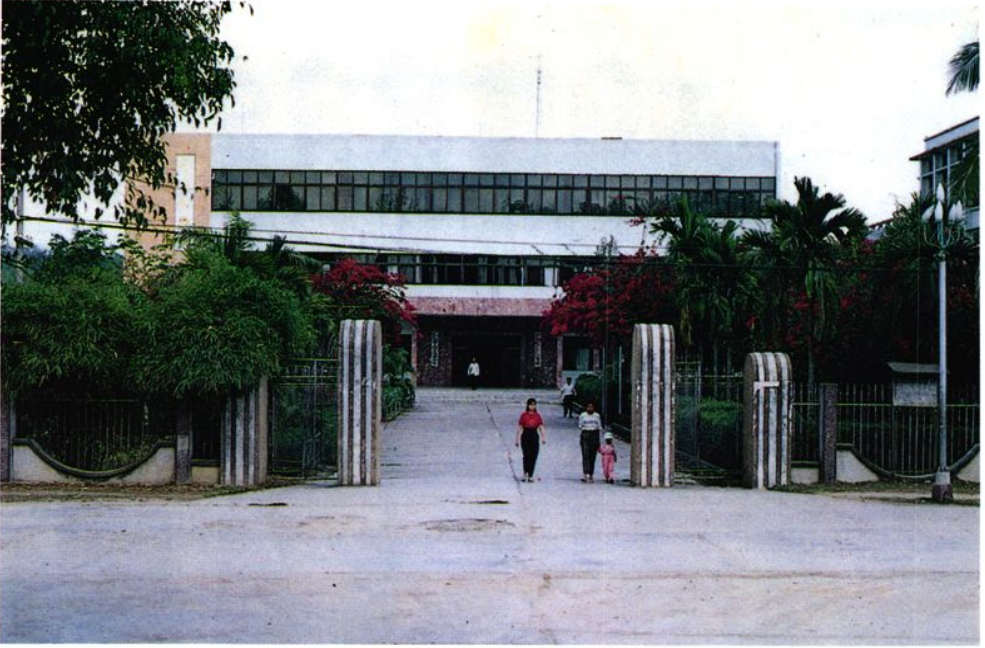
场俱乐部大楼
