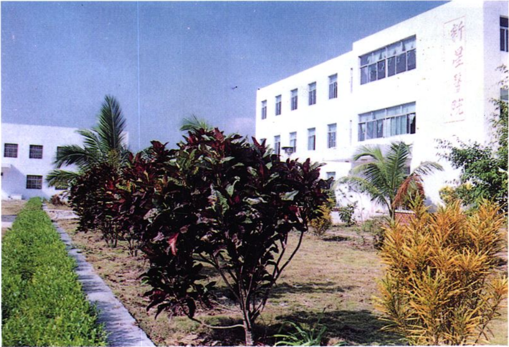
场医院门诊大楼
