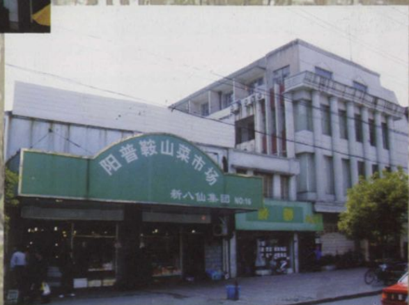
▲ 位于鞍山路101号鞍山菜市场
