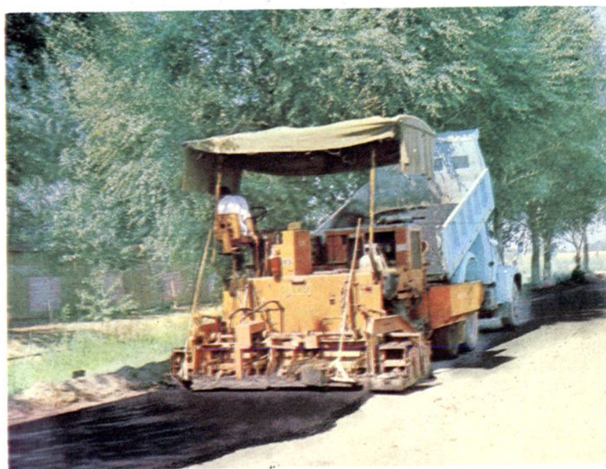
沥青混凝土摊铺机在作业
