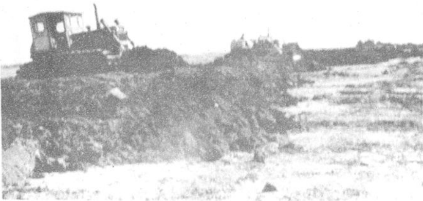
机械推筑路基
