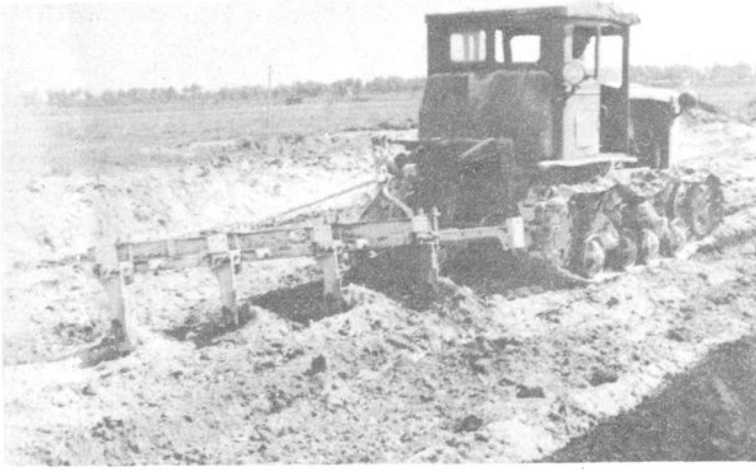
机械拌合石灰土
