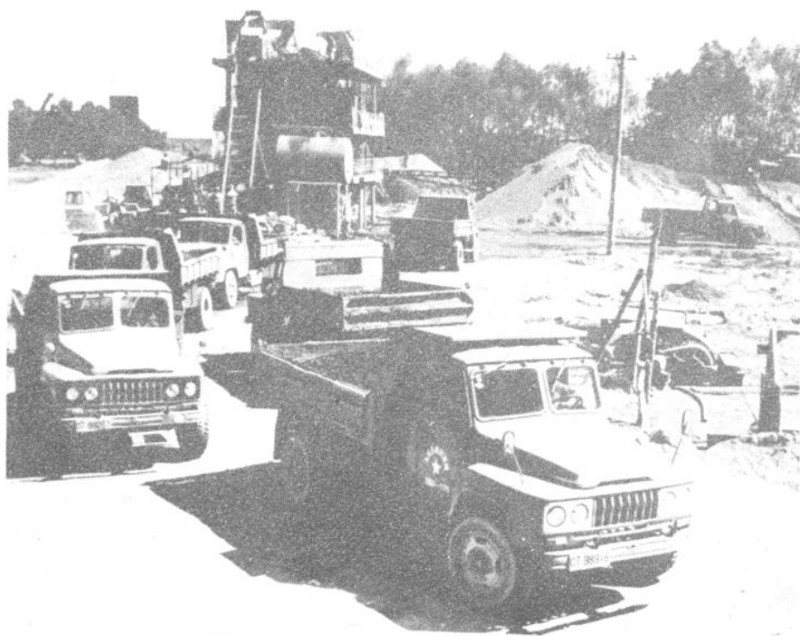
拉运水泥混凝土砂浆
