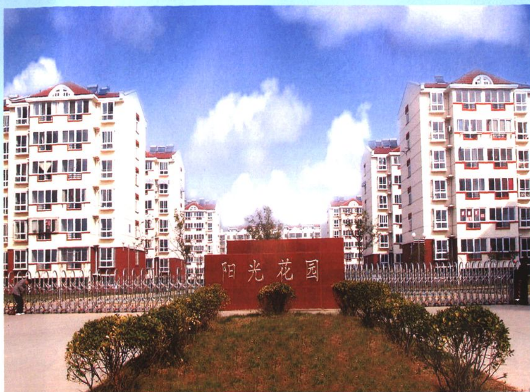
徐州市第一期经济适用房小区——阳光花园
