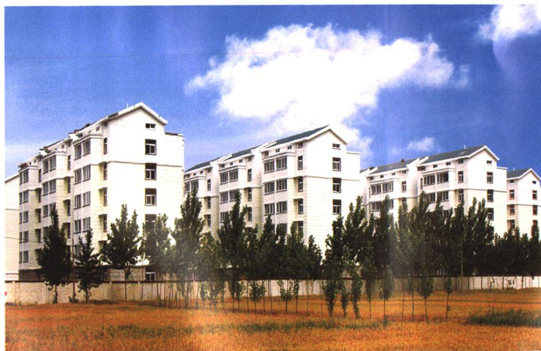
正在建设中的徐州市第二期经济适用房小区——城市花园
