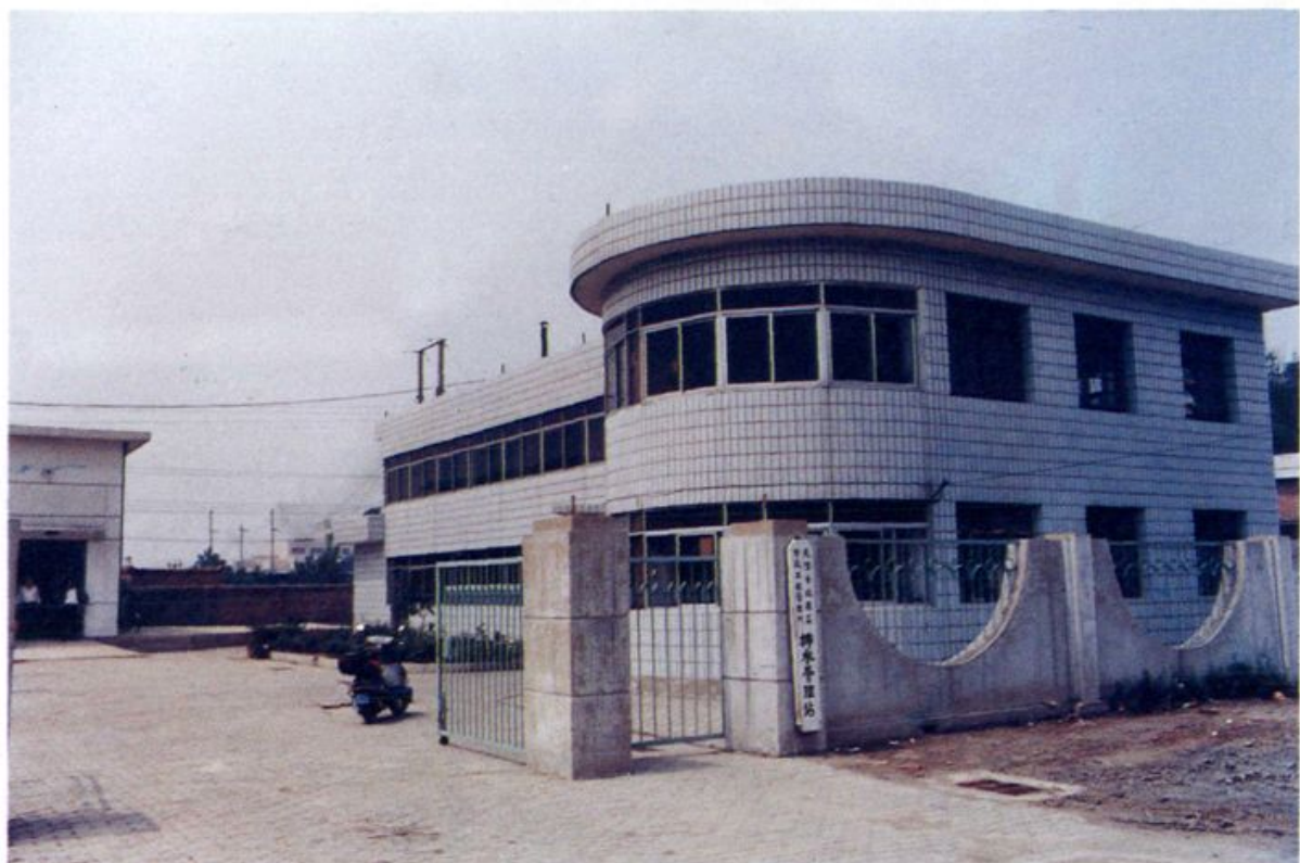
丰产河排水泵站
