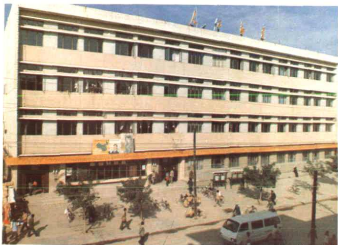
临夏回族自治州邮电局通信楼
