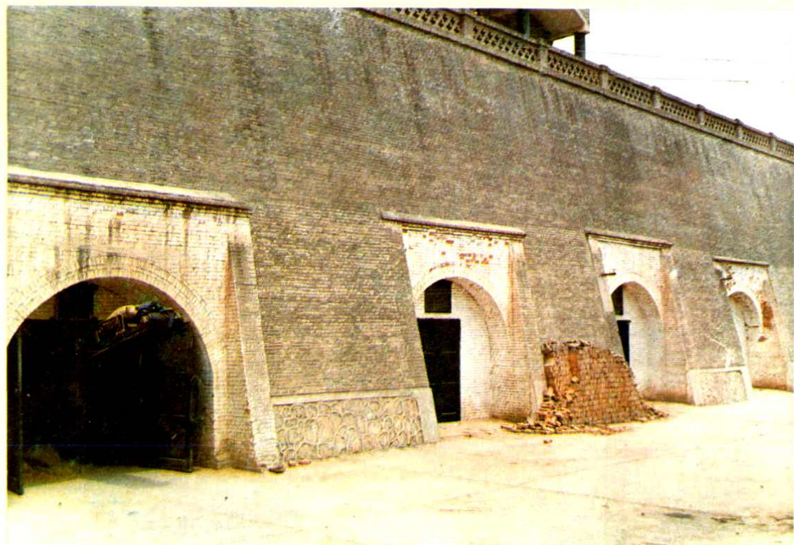
△礼泉县北屯粮站的地下仓
