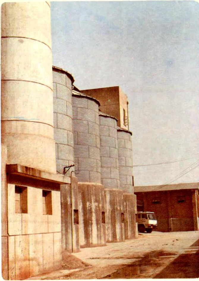
左图为武功县贞元面粉厂的钢板仓
