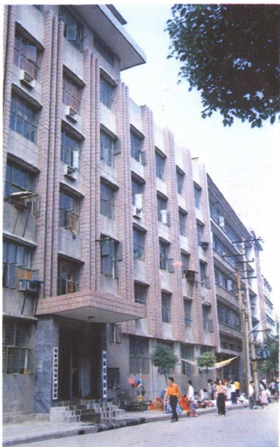
财政局机关办公大楼
