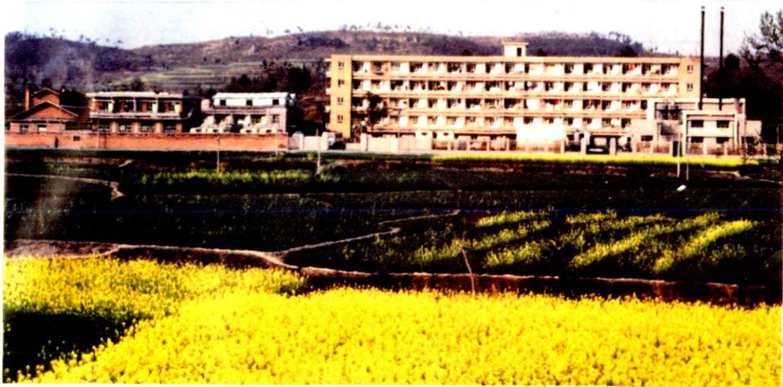
江油海棠铺地震一大队基地
