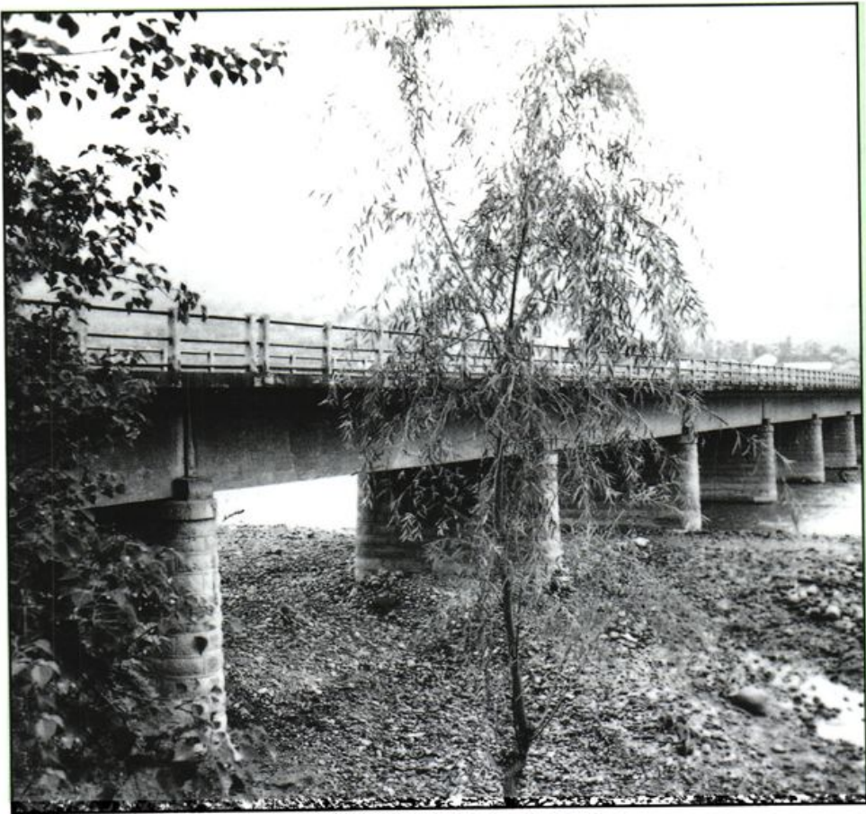
108线流沙河大桥
