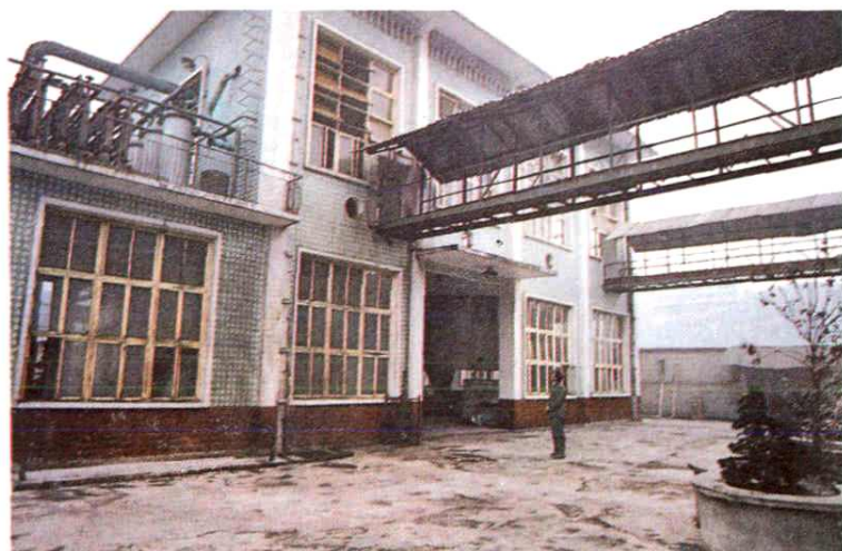
植物油厂浸油车间
