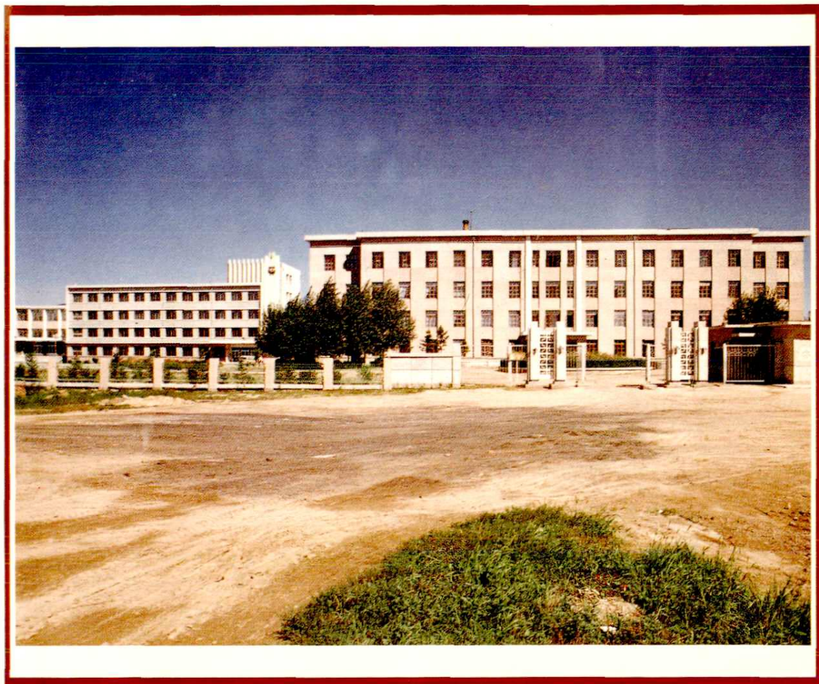
电业局正门 图左办公楼 图右生产楼
