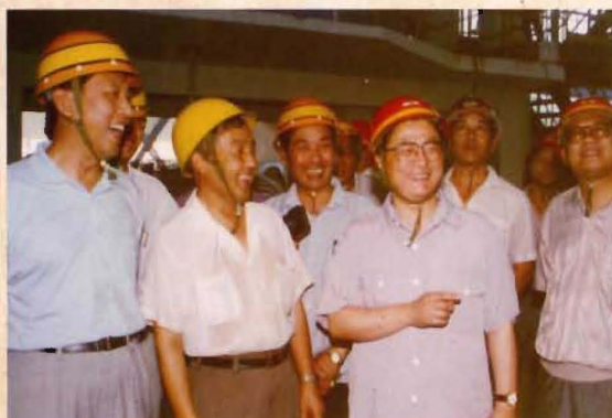
▲ 1991年，上海市市长黄菊视察上海梅山钢铁公司热轧板工程。刘壮飞、李守顺陪同并汇报工程情况
