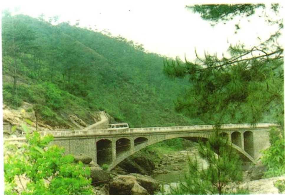
319 国道新泉一桥
