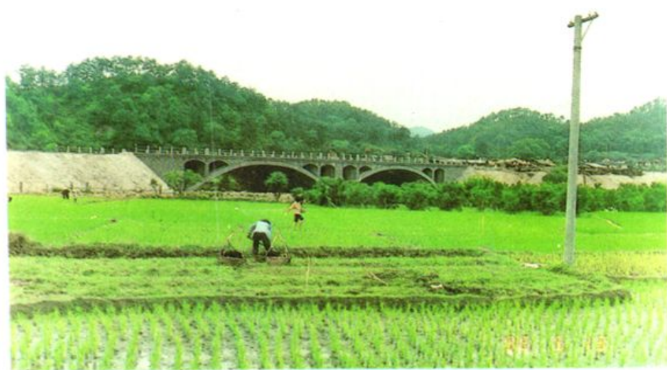
319 国道朋口大桥
