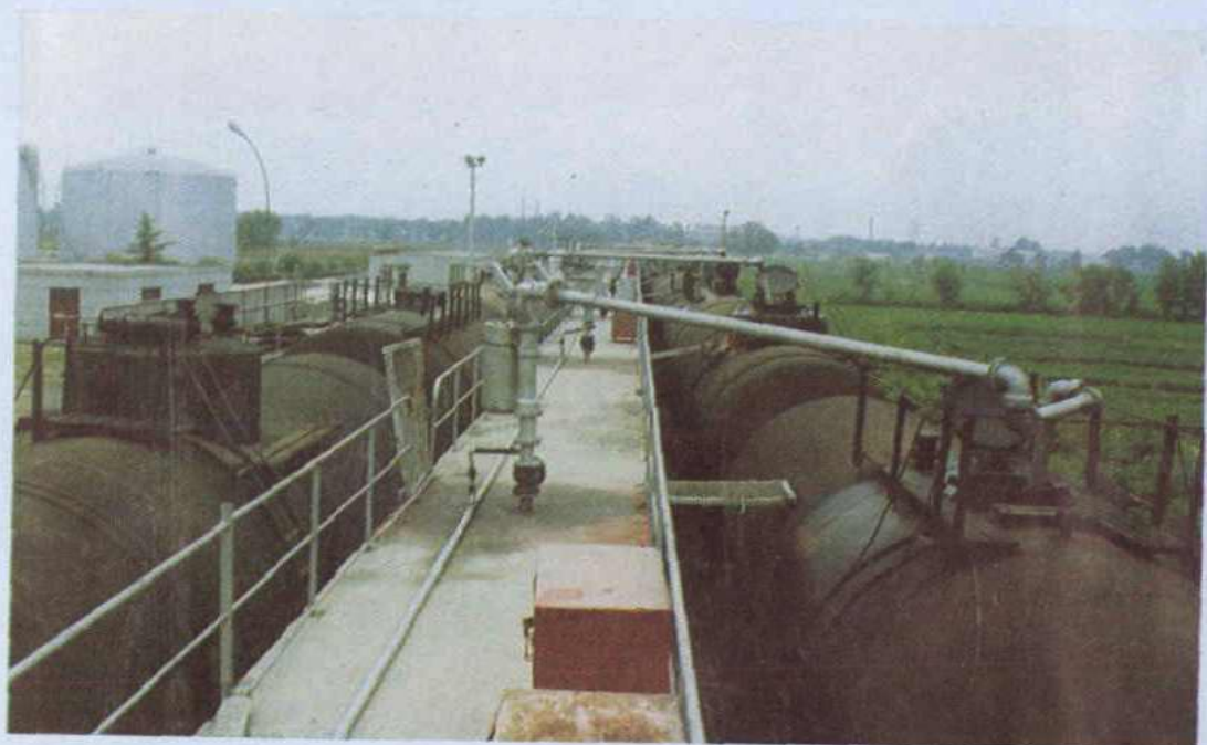
油库铁路栈桥
