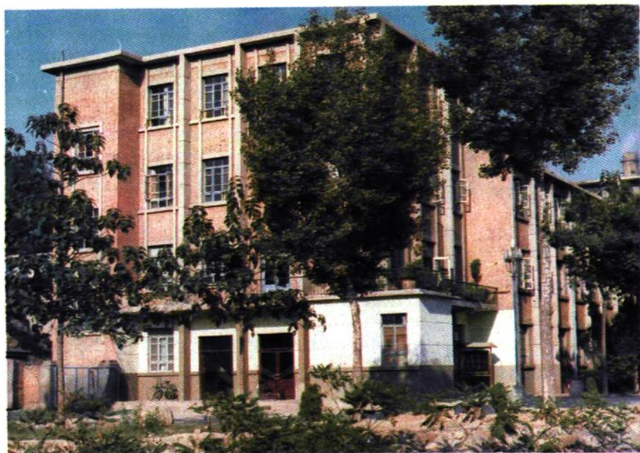
山西阳泉铝矾土矿办公主楼
