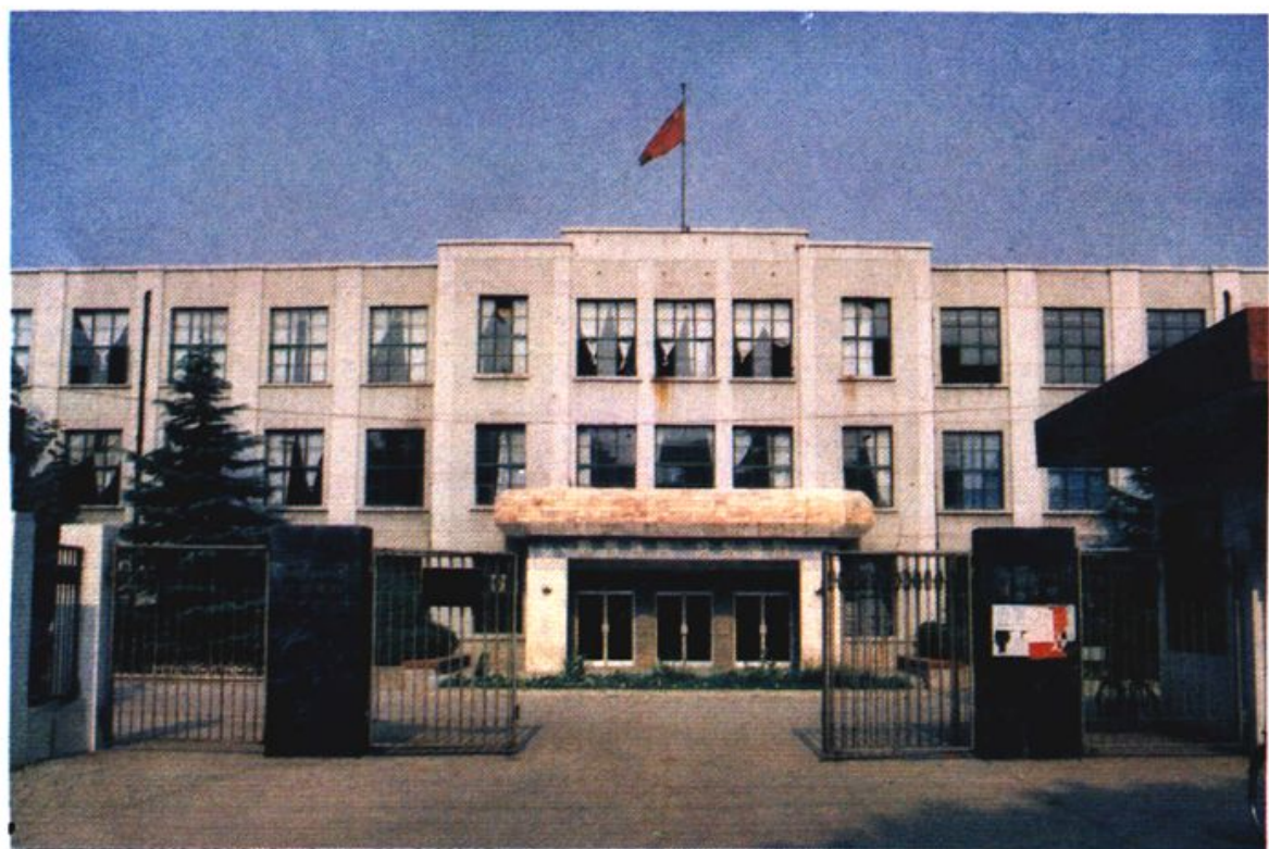
技工學校教學樓建于 1959 年建築面積 5012.98 平方米
