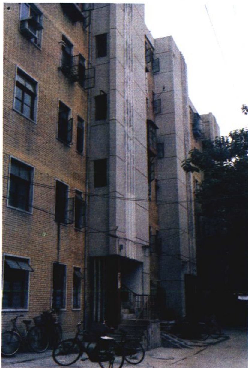
汝河小區住宅樓 1985 年購于中房公司鄭州分公司， 總建築面積 7835 平方米
