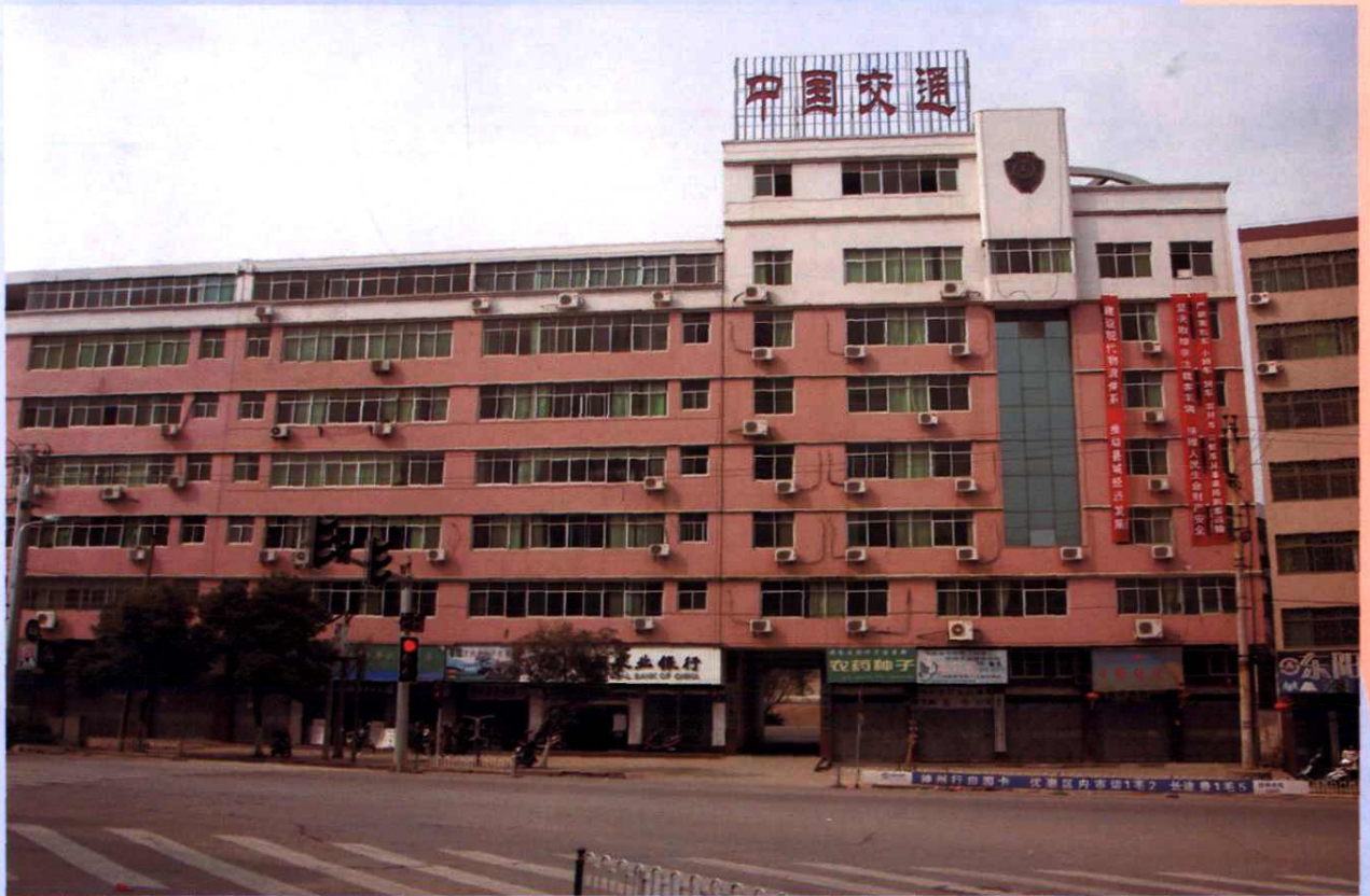
交通局办公楼
