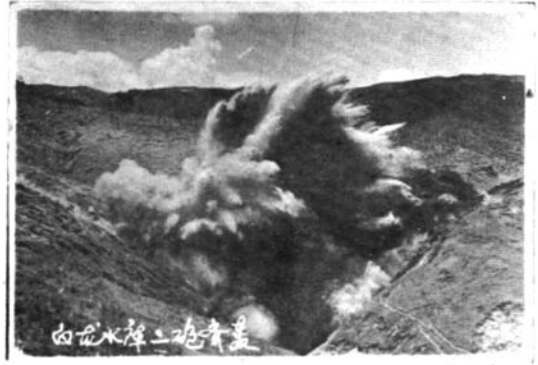
白龙水库爆破筑坝
