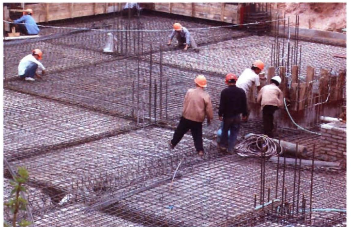
建筑工地现场
