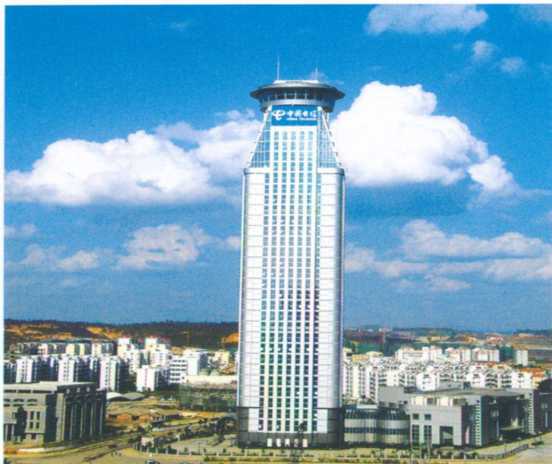
南宁第二长途电信枢纽大楼
