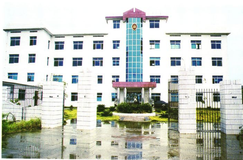
桃水工商所办公楼
