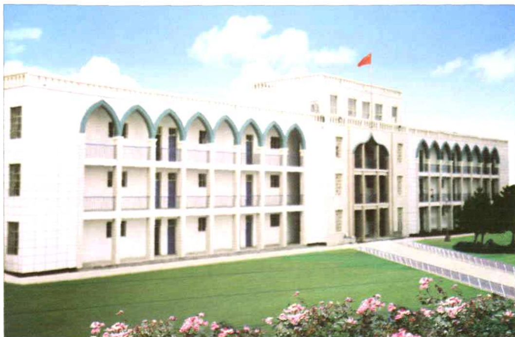
学校教学大楼
