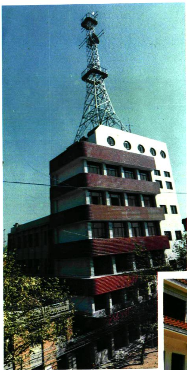
黄梅县邮电局电信综合大楼
