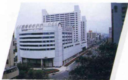
开发项目 - 观风大楼
