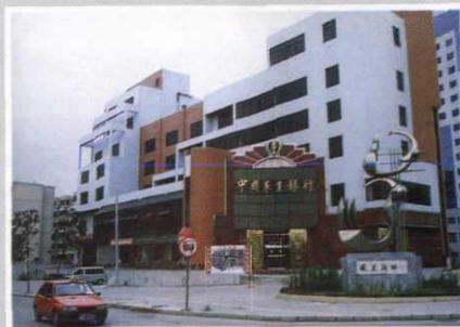
承建工程 - 凤凰小区商贸综合楼
