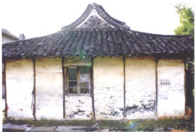
图10. 壁脚 (柱子之间砖头平放或侧放后砌的“单壁”)
