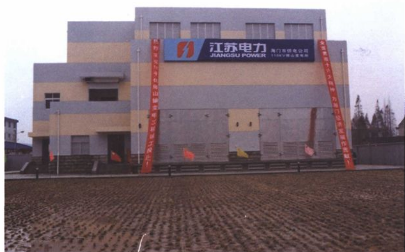
海门市第一座全室 内变电所——110千伏 师山变电所
