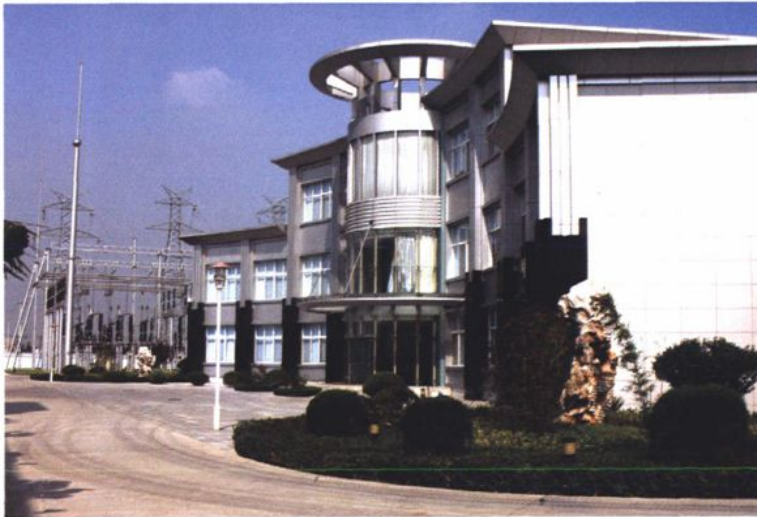
220千伏海门变电所控制楼
