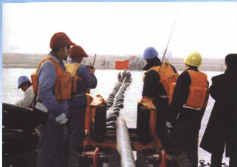
1986年10月，海门 县敷设青龙港—崇明的 110千伏海崇线过江电缆
