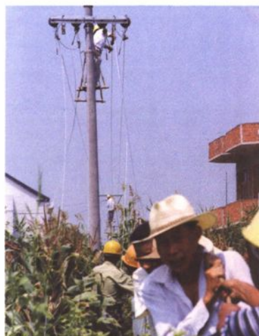
2000年8月，海门农村电 网建设与改造——10千伏线路 架线施工现场
