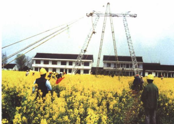
1988年4月，220千伏常中线杆塔组立施工现场
