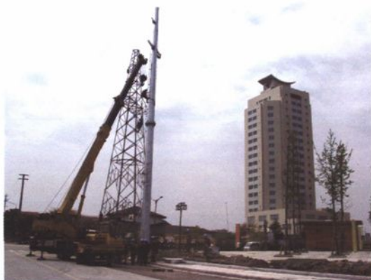
2005年4月，海门城网改造工程—— 35千伏城东线立杆施工现场
