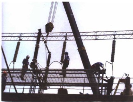
2005年7月，220千伏常乐变电所调换隔 离开关
