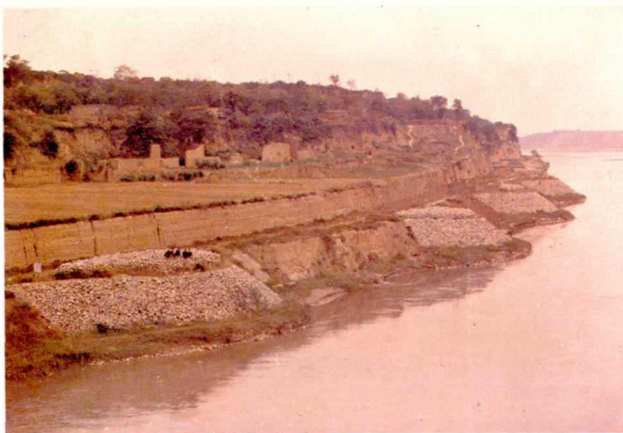
梁村险工段坝垛
