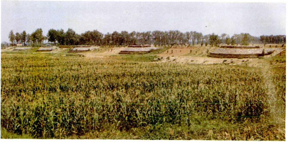
耿镇防洪大堤
