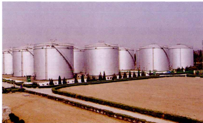
徐州分公司周宅子油库罐区,始建于1987年
