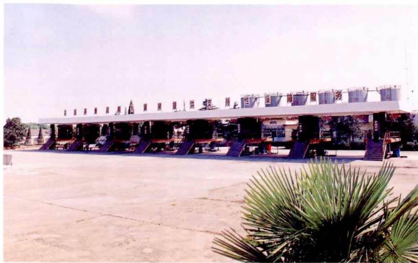
扬州分公司头道桥油库 陆路发货场,始建于1992年3 月
