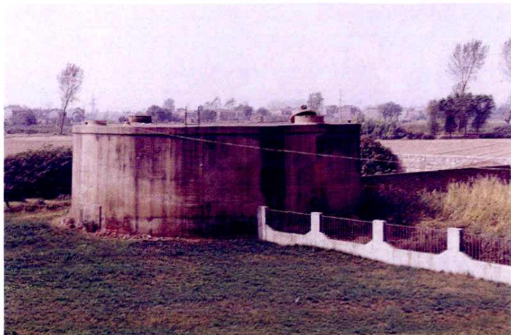
徐州分公司孙圩子油库土油罐,始建于1958年
