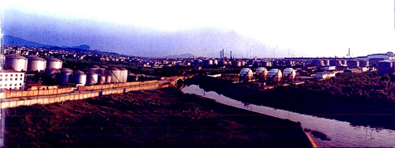
江阴分公司长山油库罐区全貌
