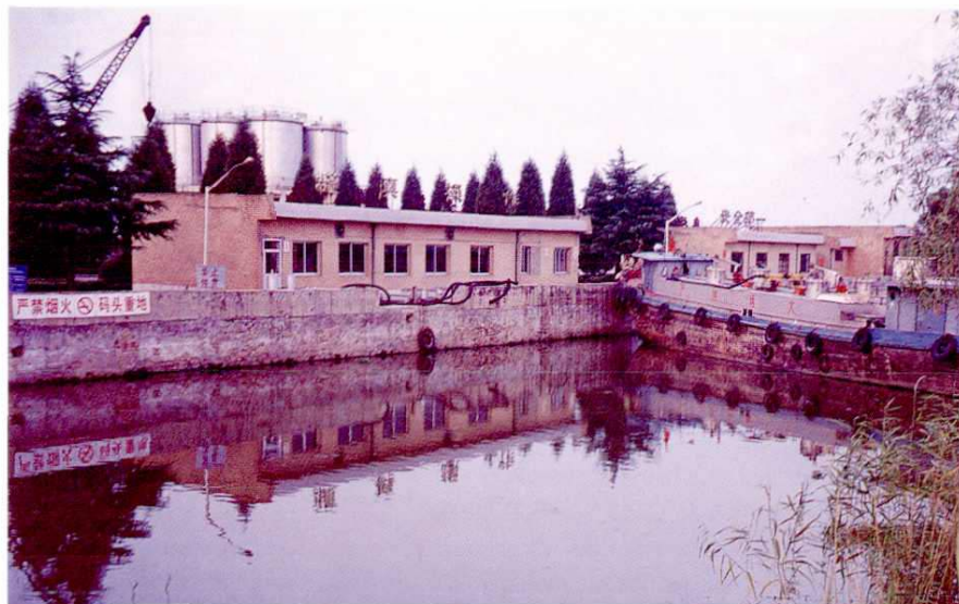
溧阳支公司后袁油库内 河码头,始建于1991年9月
