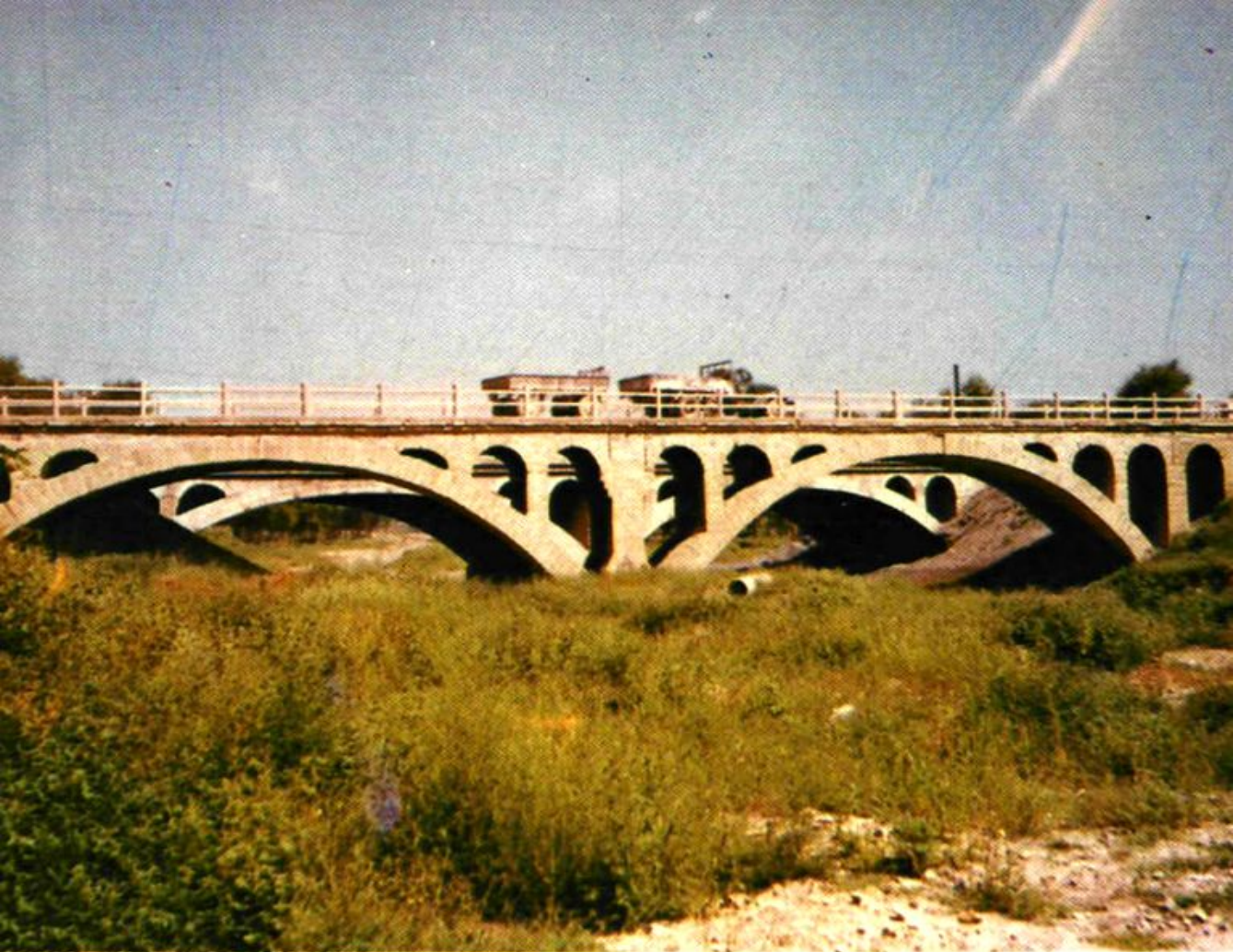
省级公路建三线塔城双桥
