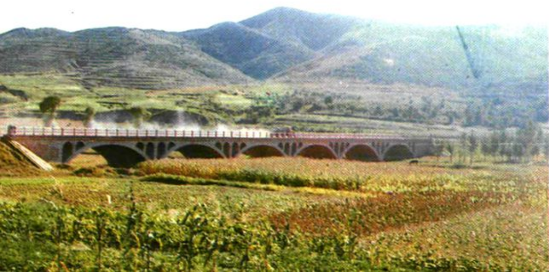
朝大公路小马架子桥
