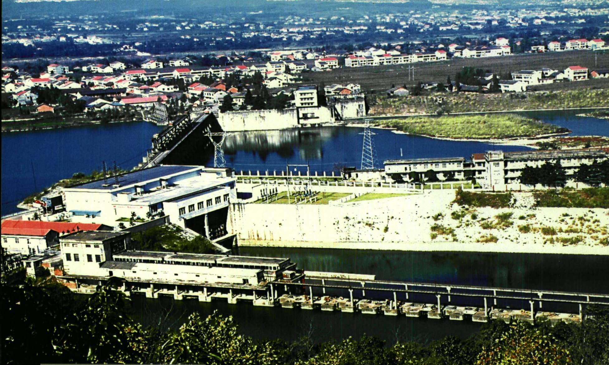
— 临澧县青山水轮泵站工程全景
