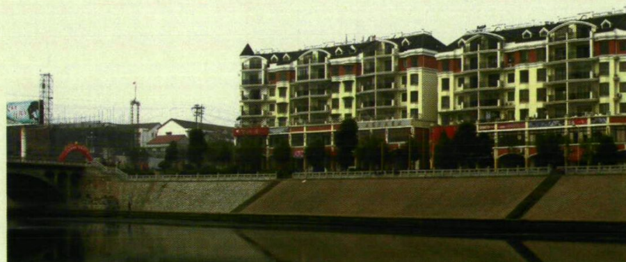
道水安福大堤
