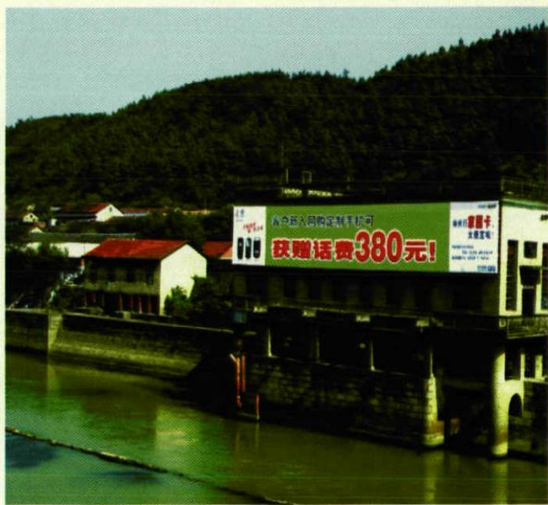
县烽火水轮泵站
