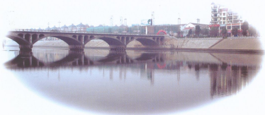
临澧道水大桥全景
