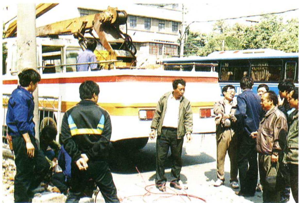
城建局曾广禄局长、路灯管理处张炳寒主任现场指挥作业
